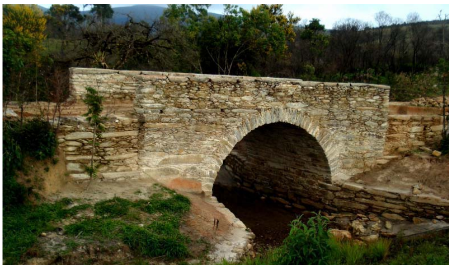
Ponte perto da estrada entre Ouro Preto-MG e Ouro Branco-MG.
